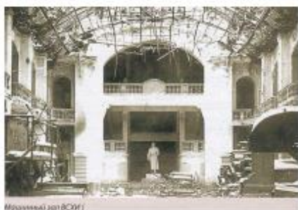
Рисунок 2 – Разрушенные фашистами здания ВСХИ
